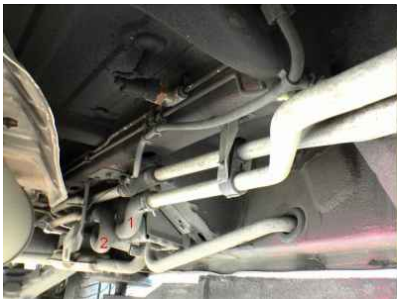
Přívod a odvod vody Bufíku, který je potřeba zaškrtit
